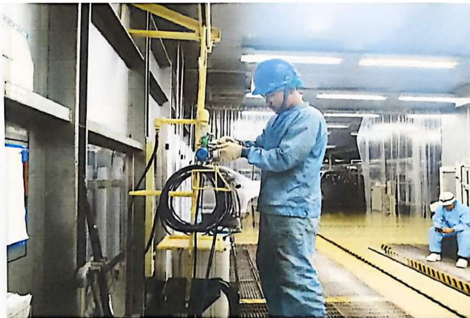
Gambar 1.24 Pemasangan pipa dan hanger gan
