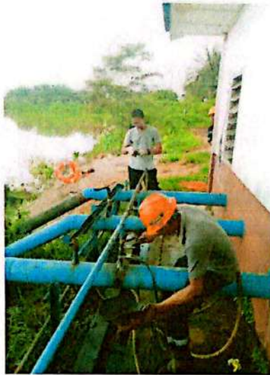
Gambar 2. 7 Pengelasan Pipa Air Baku Perumahan PT
