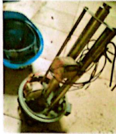
Gambar 2. 8 Membantu Membersikan Mobrey Di Stasiun Boiler
