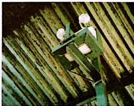
Gambar 2. 17 Membantu Memasang lampu emergency
