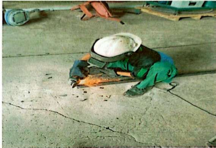
Gambar 2.4 Memotong pipa besi untuk pembuatan rak pipa-pipa boiler
