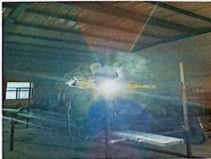
Gambar 2.5 Pengelasan pembuatan rak untuk menaruh pipa-pipa boiler
