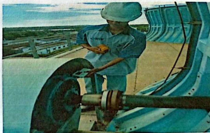
Gambar 2.9 Kegiatan pengambilan vibrasi dan suhu
