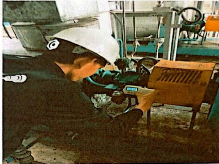
Gambar 2.12 Pengambilan suhu dan vibrasi
