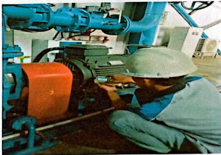
Gambar 2.11 Kegiatan pengambilan vibrasi dan suhu
