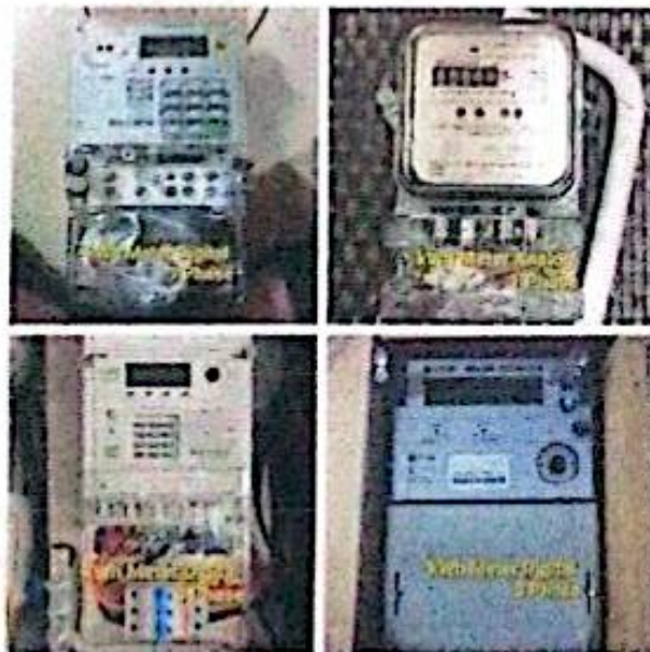
Gambar 2.1 kWh Meter 1 Phase dan 3 Phase
