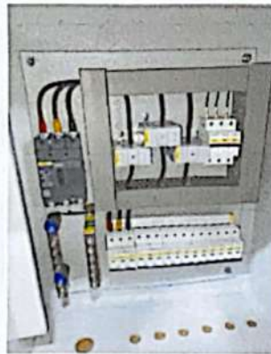
Gambar 2. 7 Hasil Penempelan tape untuk Marking Komponen
