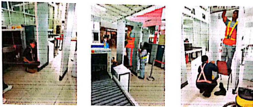
Gambar 2. 12 Kegiatan Kalibrasi dan Maintenance Pada WTMD
