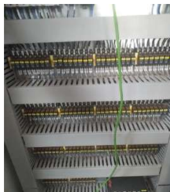
Gambar 2.5 Hasil penempelan tagging di relay
