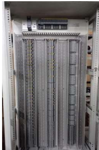
Gambar 2.16 Hasil pemasangan DLM pada stopper
