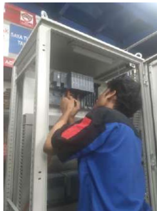
Gambar 2.9 Mewiring modul DI Simatic Siemens ET 200sp
