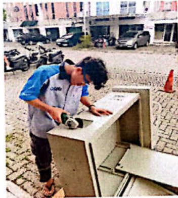
Gambar 3. Pembuatan Lobang Exhaust Fan
