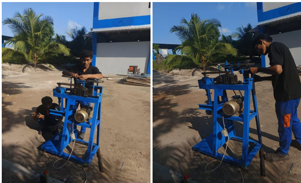
Gambar 4. 8 Proses Pemasangan Mesin
