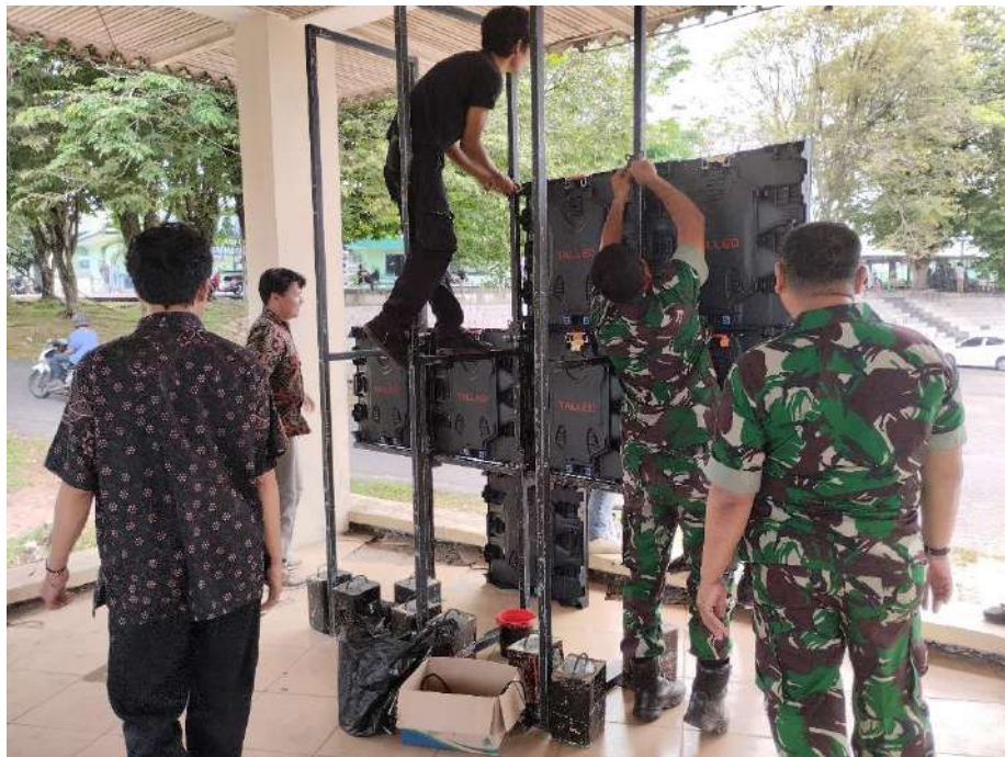
Gambar 2.2.2 : Pemasangan Video Tron Di Gedung Nasional
