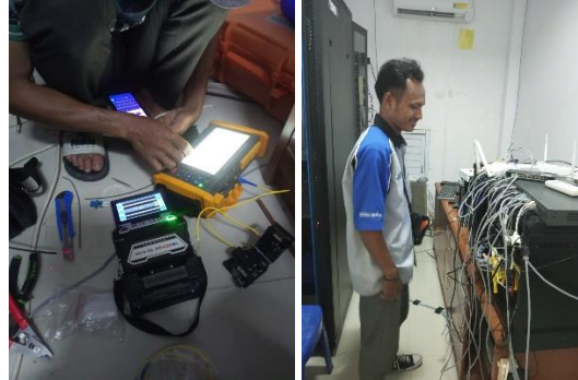
Gambar 2. 3 Menginstalasi Jaringan di Rumah Saki Umumt
