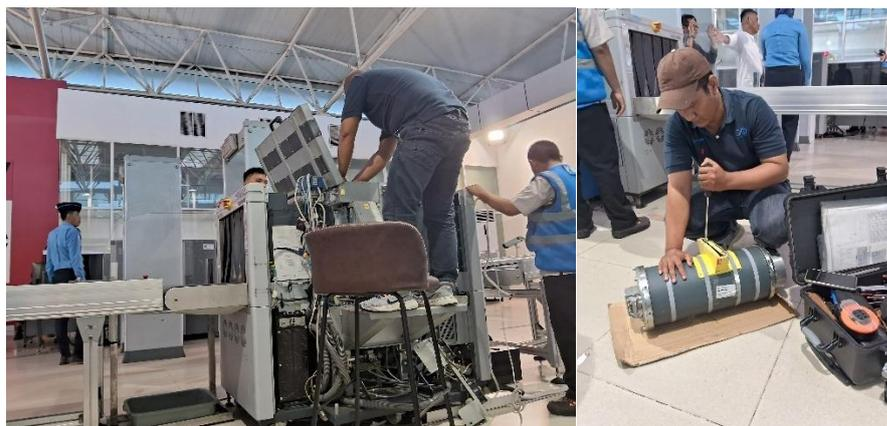
Gambar 2.22 Mengganti Tank Head pada X-ray di SCP 2
