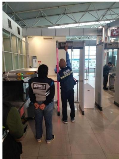
Gambar 2.12 Pemeliharaan WTMD
