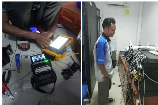
Gambar 2. 3 Menginstalasi Jaringan di Rumah Saki Umumt
