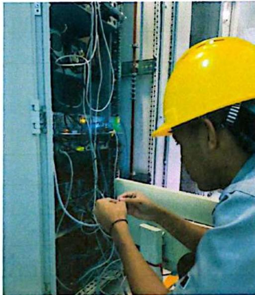
Gambar 2 Instalasi jaringan server SCADA
