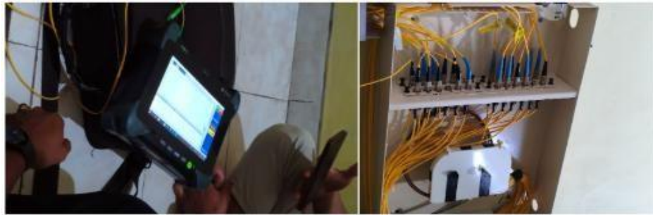
Gambar 9.Rekonfigurasi Port Ethernet Multiplexer
