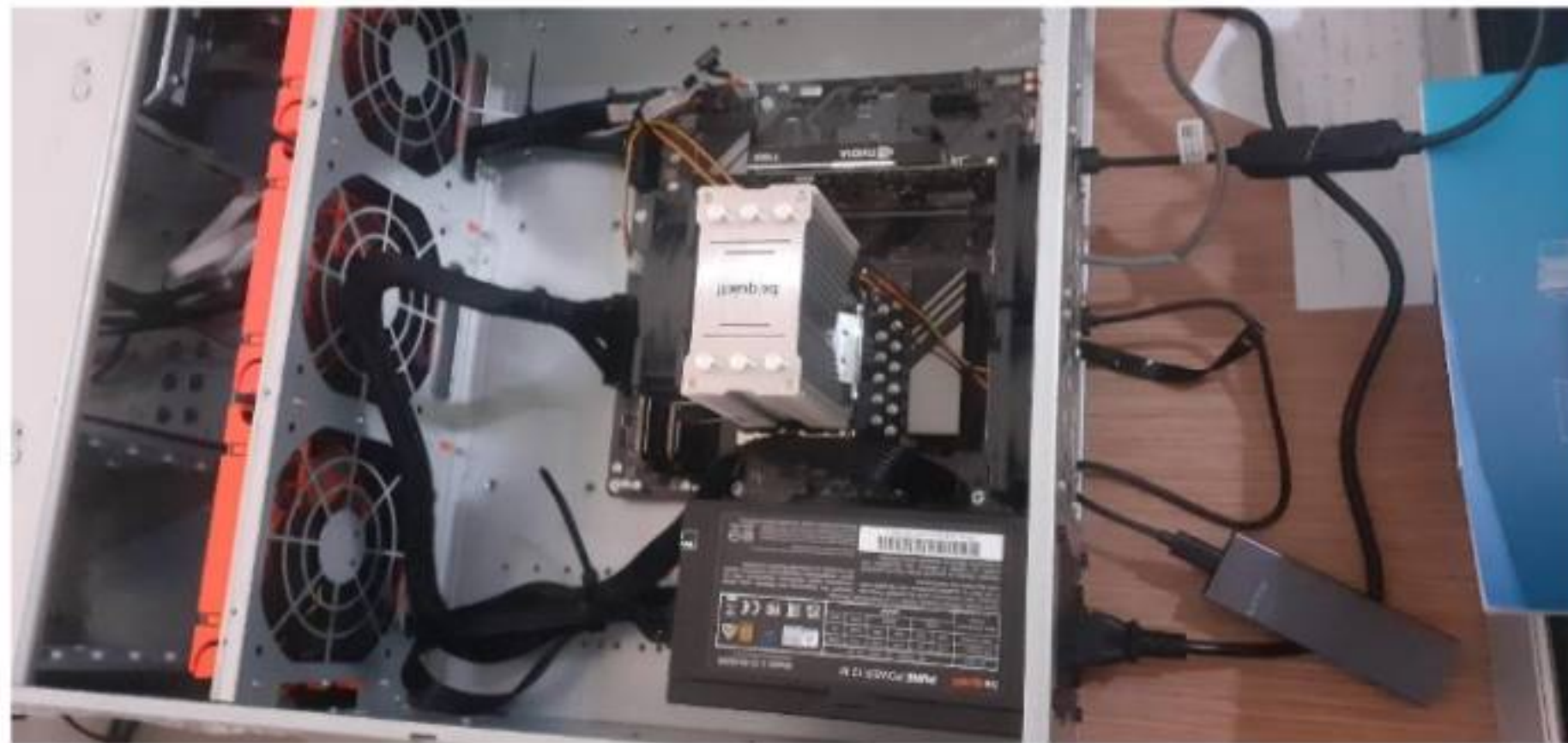
Gambar 2. 11 Proses Perakitan Server
