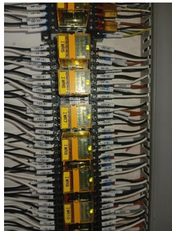
Gambar 2. 14 Hasil penempelan tagging panel mill PT. INDOLAMPUNG PERKASA
