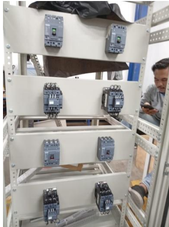
Gambar 2. 9 Pemasangan kontaktor dan MCCB Panel PT. TIMAH Tbk
