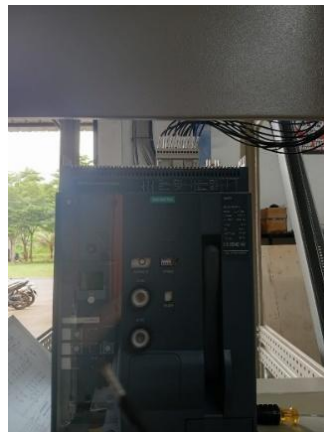
Gambar 2. 10 Pemasangan ACB Panel PT.TIMAH Tbk
