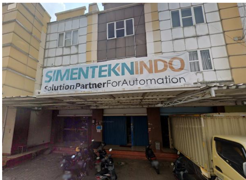
Gambar 1. 4 Kantor PT Simenteknindo
