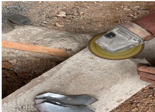
Gambar 4. 7 Pemotongan *Blade Impeller*
