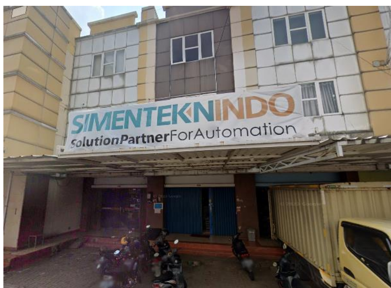
Gambar 1. 3 Kantor PT. Simenteknindo
