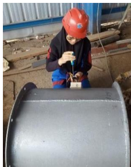
Gambar 2.3 Penyambungan Kabel Pada Marine Axial Fan
