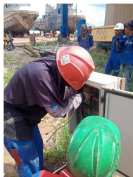
Gambar 2.1 Penyambungan Kabel Antar Panel
