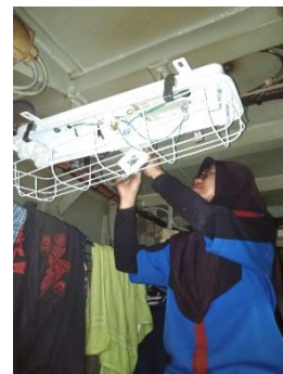
Gambar 2.4 Penyambungan Kabel Pada Lampu TL
