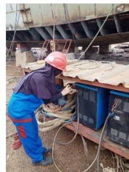
Gambar 2.2 Penyambungan Kabel Untuk Trafo Las
