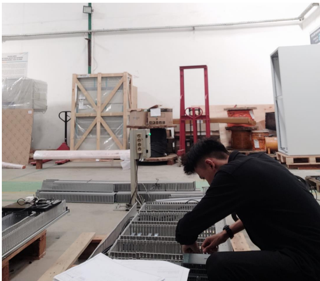
Gambar 2. 4 Proses Pengerjaan Panel Untuk PT. Cikarang Listrindo
