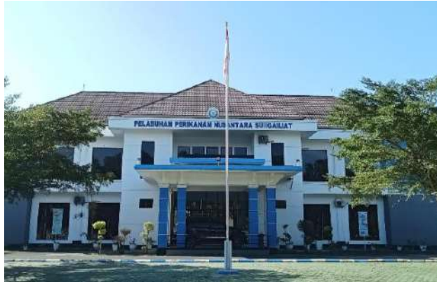
Gambar 1. 2 Kantor Pelabuhan Perikanan Nusantara Sungailiat
