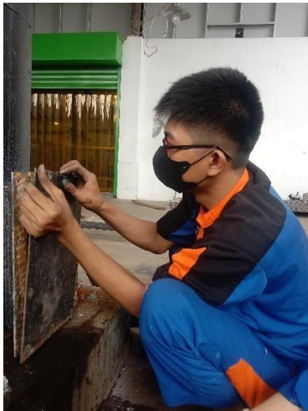
*Gambar 2. 6 Pemasangan Gasket Saluran Boiler*
