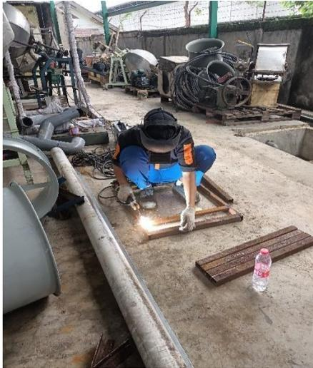
*Gambar 2. 3 Pengelasan Untuk Dudukan Mesin Mixer*
