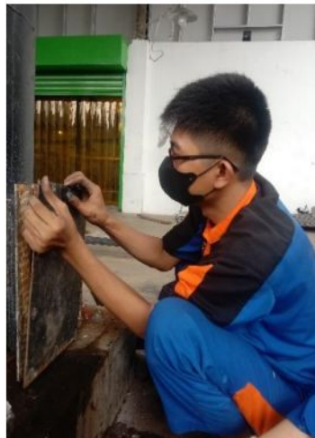
Gambar 2. 4 Pemasangan gasket pada saluran boiler
