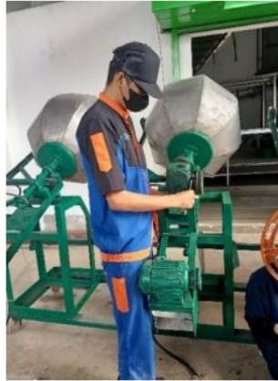
Gambar 2. 8 Pemasangan Gear Box Mesin Molen
