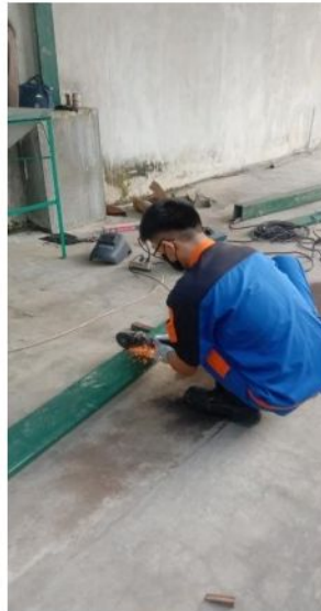
Gambar 2. 2 Membuatudukan pipa pembuangan air hujan
