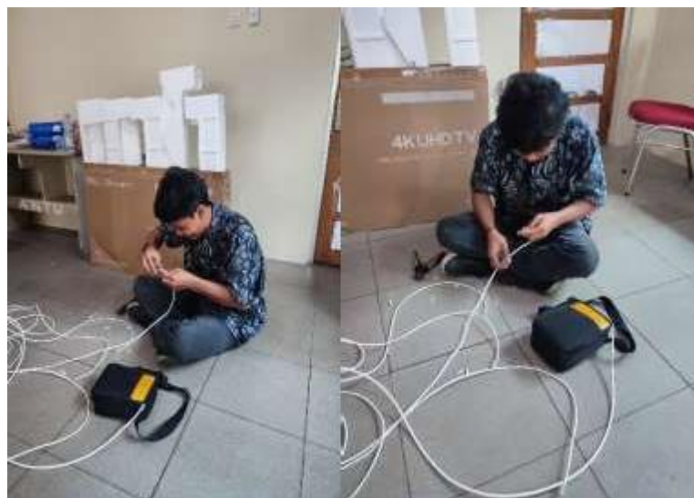
Gambar 2. 4 Crimping Cabel LAN
