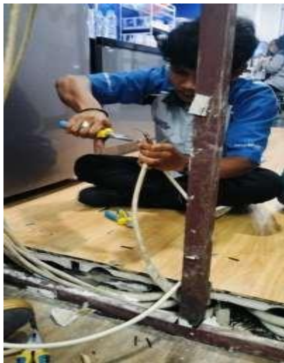
Gambar 2. 2 Mutusan Dan Menyambung Kabel NYM
