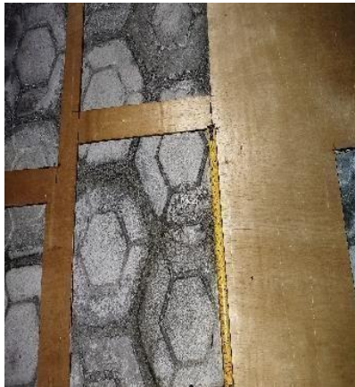
Gambar 4. 10 Pengukuran lebar 300 mm (Dok.Pribadi)
