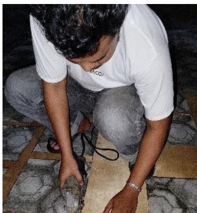
Gambar 4. 12 Pemotongan Triplek (Dok.Pribadi)
