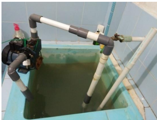
Gambar 4.38 Pengujian alat pada bak
