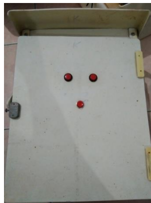
Gambar 4.29 Push-button pada pintu box panel
