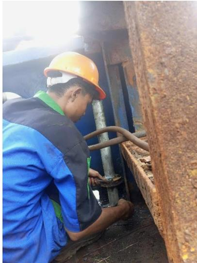
Gambar 2.9 proses pemasang pipa air tawar
