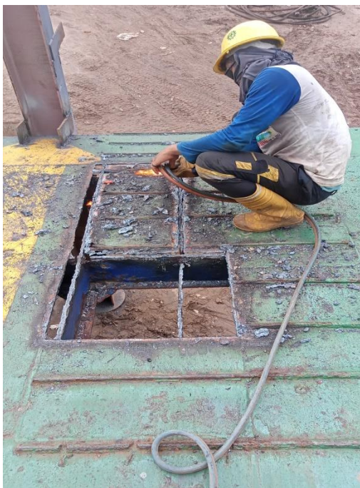
Gambar1.31 Repair lantai Ramp Door depan.
