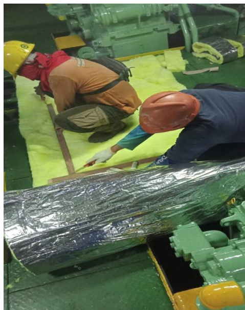
Gambar1.34 Pemasangan Glasswool Alumunium.
