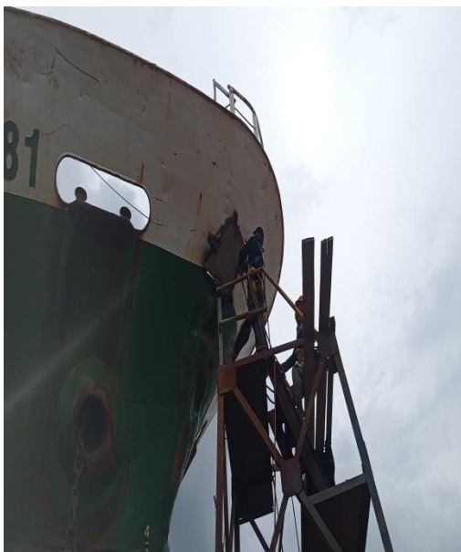
Gambar1.33 Repair Dinding haluan depan kapal INTAN-81.
