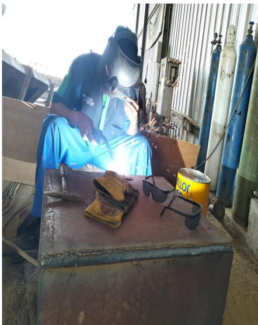
Gambar 1.27 Pengelasan Pondasi Crane Kapal Geotin New 1.
