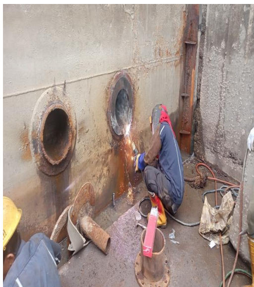
Gambar 1.29 Join Pipa dan Bongkar Pasang Valve.
