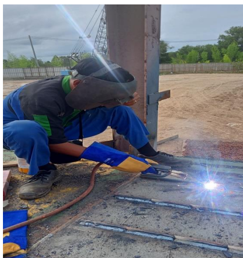
Gambar1.25 Melakukan Pengelasan Ramp Door.
