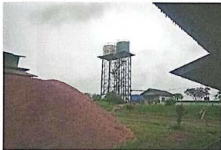
Gambar 2.24 Stasiun Water Treatment (WTP)
