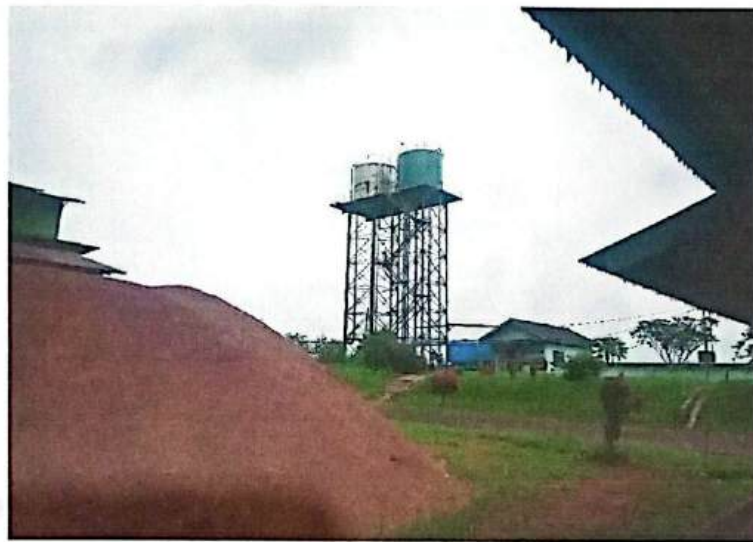
Gambar 2.24 Stasiun Water Treatment (WTP)
