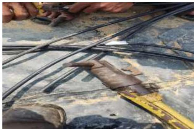
*Gambar 2. 6 Proses Penyambungan Skun Kabel*
