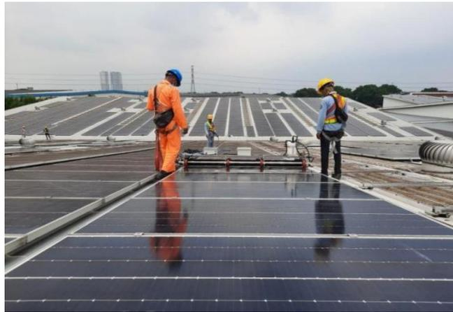
Gambar 2.4 Pembersihan Panel Surya Menggunakan *Robot Solar Cleaner*
