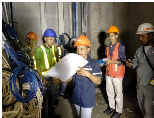
Gambar 2. 8 Tes Continuity Kabel BAS
