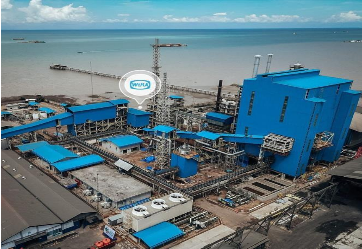
Gambar 1.1 Proyek EPCC TSL AUSMELT MUNTOK BANGKA BARAT
