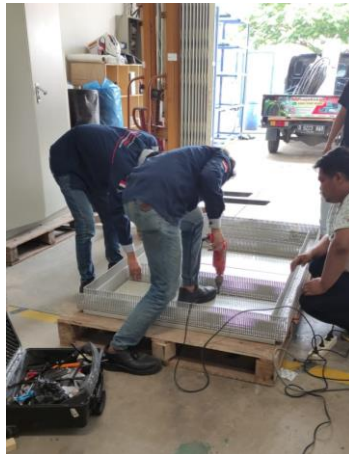
Gambar 2. 4 Pemasangan Komponen Panel
