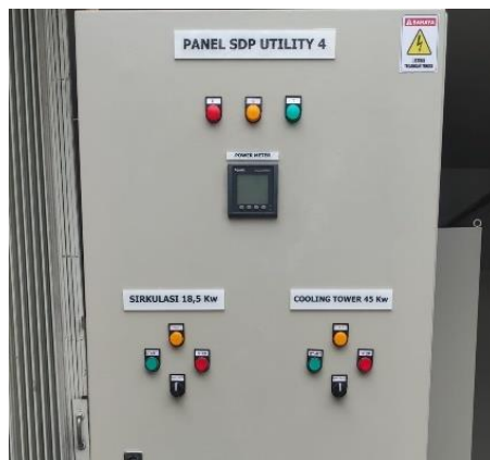
Gambar 2. 5 Contoh Komponen yang Terpasang pada Pintu Panel
