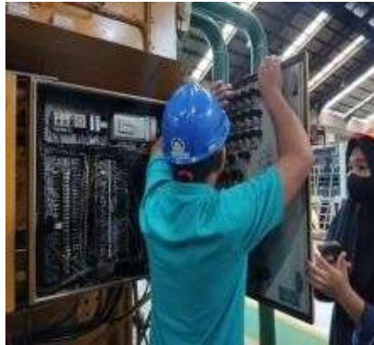
Gambar 2.12 Memeriksa parameter, instrument, metering, dan indicator
