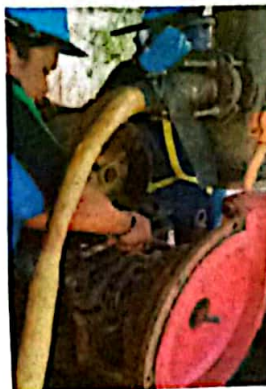
Gambar 2.0 Perbaikan Pompa Tailing
