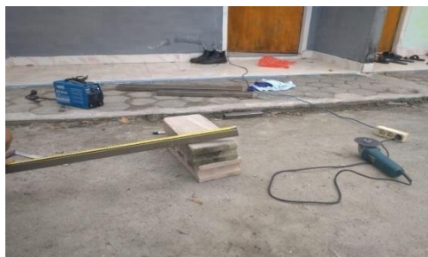
Gambar 4. 11 Pemotongan Square Hollow
