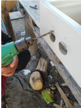
Gambar 4.2 Pemotongan Atau Pengeboran Panel
