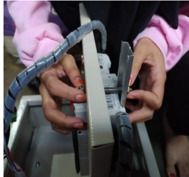
Gambar 4.4 Pemasangan Komponen pada panel
