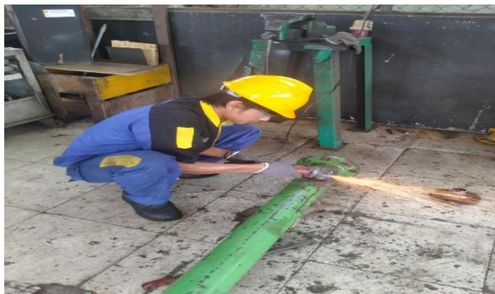
Gambar 2.8 perbaikan pipa air pendingin MaK
