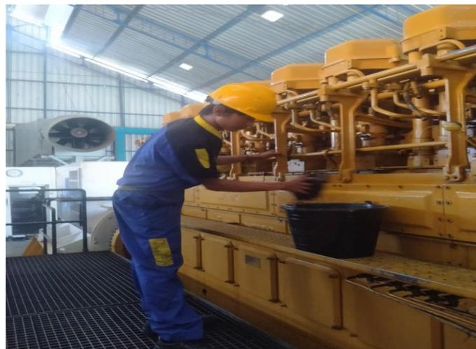
Gambar 2.6 PO mesin cek kebersihan filter bbm dan kebersihan mesin + bordesk
