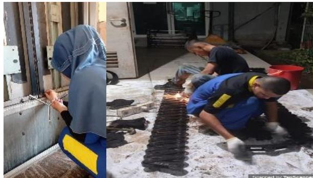
**Gambar 2.3** penggantian *Doorshoes* (sepatu pintu) pada lift dan penggantian roller pada eskalator
