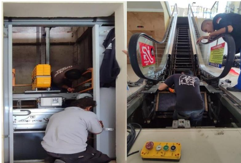
**Gambar 1.3** Proses instalasi elevator (lift) dan eskalator
