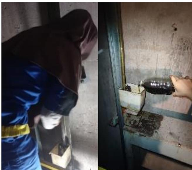
**Gambar 2.1** Proses pelumasan di rel alur sangkar dan rel alur CWT pada lift
