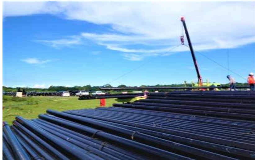
Gambar 2.3 Proses Pengangkutan Pipa
