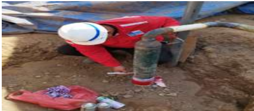
Gambar 2.9 Proses Liquid Penetrant Test pada Pengelasan Joint Pipa
