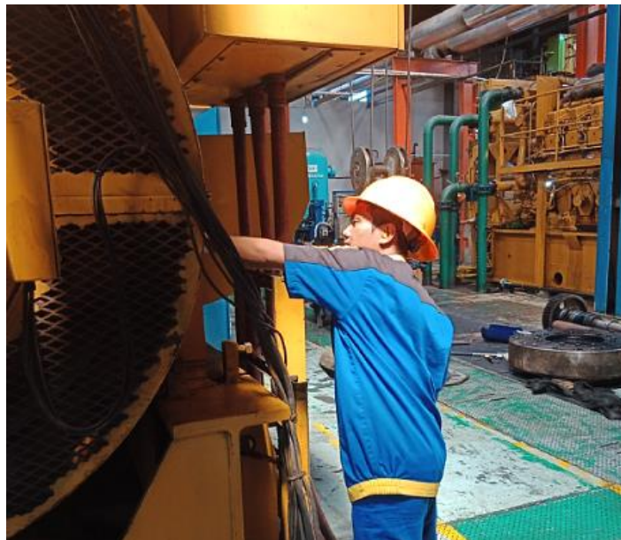
Gambar 2.3 Preventive Maintenance pada Area Mesin Caterpillar
