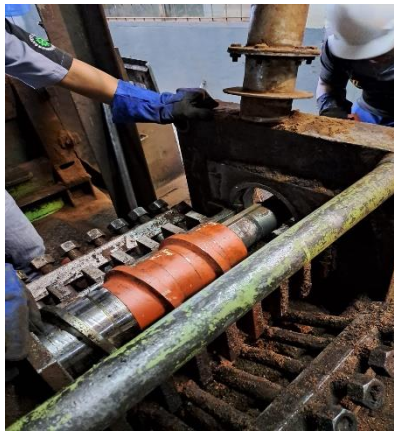
Gambar 2. 8 Pemasangan Worm Sesuai Urutan
