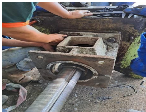
Gambar 2. 6 Pemasangan Feed Cage
