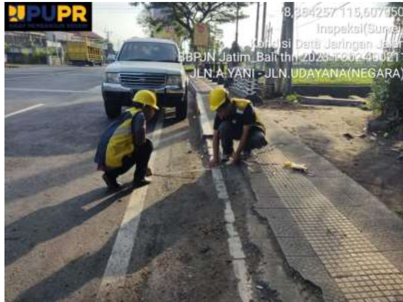
Gambar 2. 6 Pengukuran Jalan TC 2
