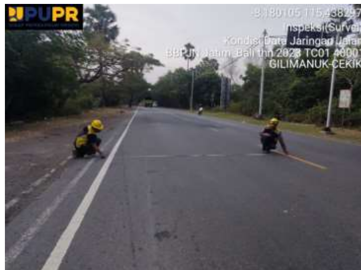
Gambar 2. 3 Pengukuran Jalan TC 1
