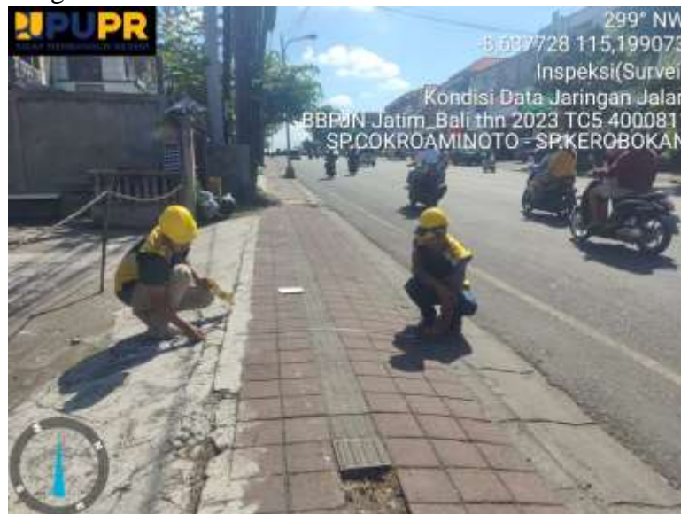
Gambar 2. 15 Pengukuran Jalan TC 5
