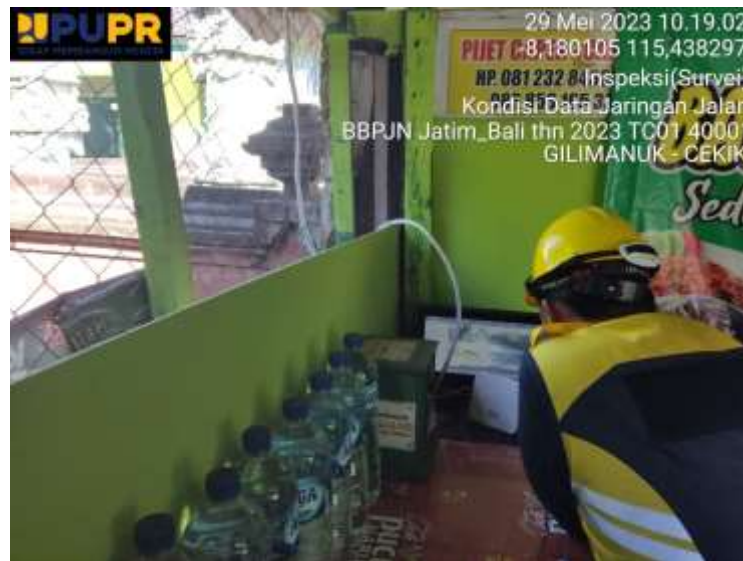
Gambar 2. 2 Pemasangan Monitor CCTV TC 1
