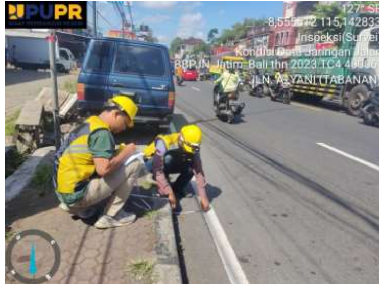
Gambar 2. 12 Pengukuran Jalan TC 4
