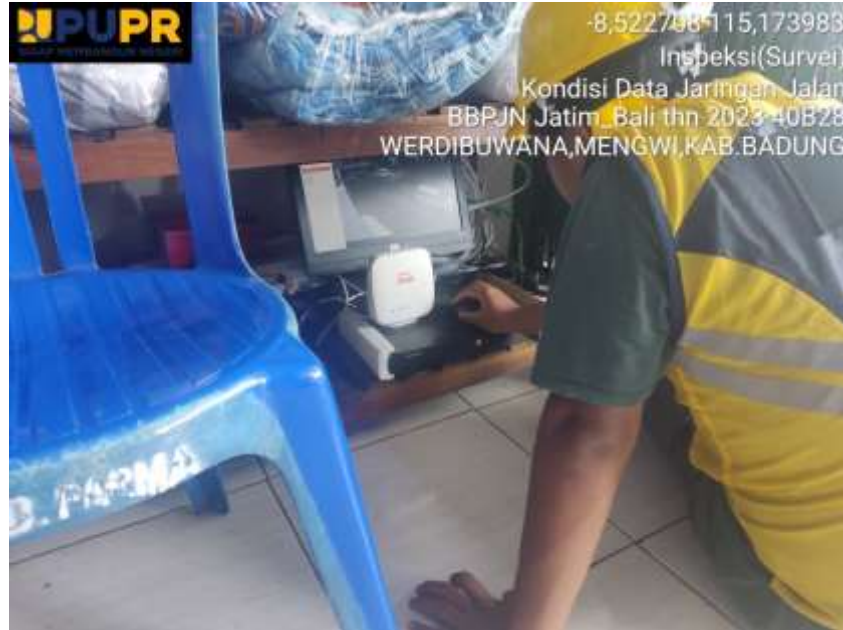
Gambar 2. 31 Pemasangan Monitor CCTV BS 4
