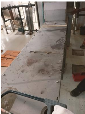
Gambar 2. 22 Memasang Tutup Bodi Screw Coneyor
