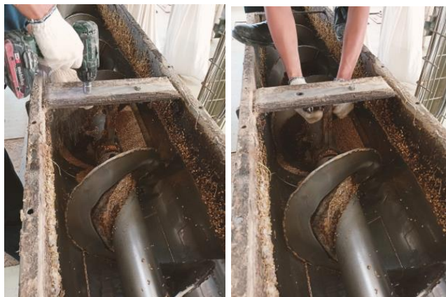
Gambar 2. 16 Membuka Baut Gantungan Metal
