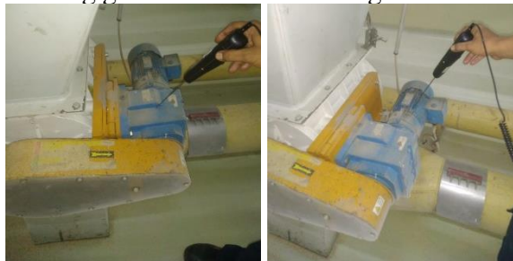
Gambar 2. 9 Mengecek suara Gearbox dan Motor
