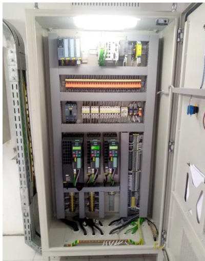
Gambar 2. 7 Kondisi kabel di Panel PLC setelah dirapihkan
