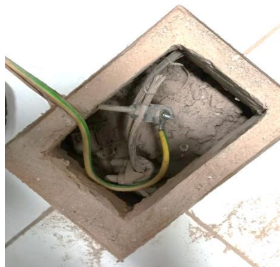
Gambar 2. 8 Pemasangan Grounding ke pembumian
