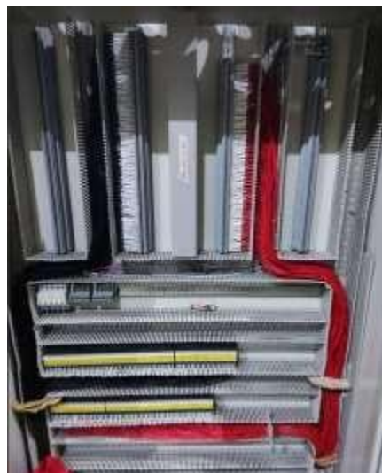
Gambar 2. 15 Proses Wiring dan Terminasi pada panel Marshalling 2 PT. Pupuk Kujang Cikampek
