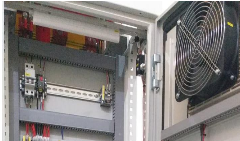
Gambar 2. 11 Wiring Limit Switch, fan dan lampu pada panel PLC PT. Quantum Karya Persada
