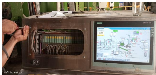
Gambar 2. 13 Pemasangan Akrluk baru PT. Djabesmen
