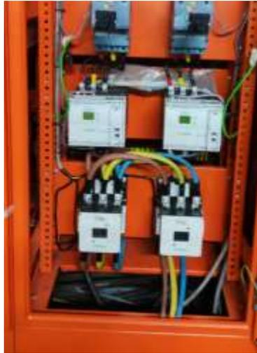
Gambar 2. 4 Kontaktor 3 phasa untuk motor *Feeder Breaker*
