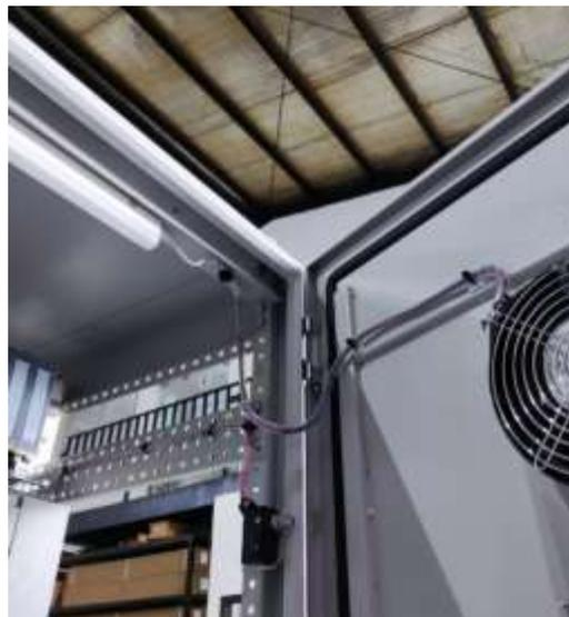
Gambar 2. 10 Wiring Limit Switch, fan dan lampu pada panel PLC PT. Quantum Karya Persada
