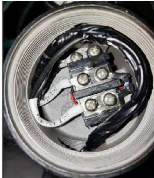
Gambar 2. 12 Wiring pada control valve mixing tank 1 dan 2
