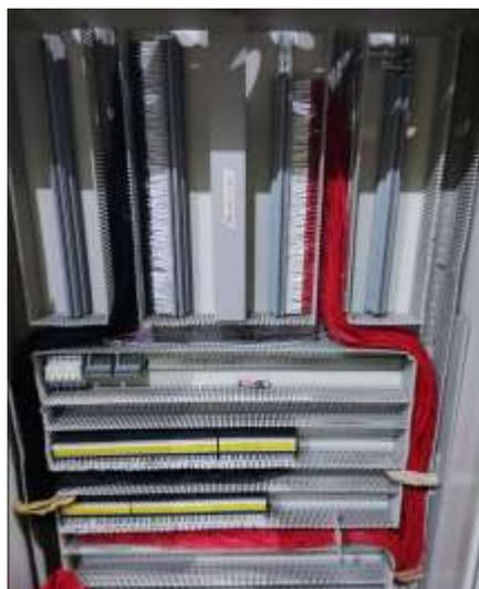
Gambar 2. 19 Proses *Wiring* dan Terminasi pada panel Marshalling 2 PT. Pupuk Kujang Cikampek
