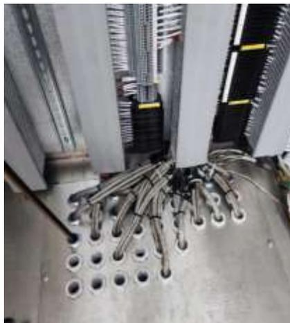
Gambar 2. 7 Kondisi kabel di Panel Remote I/O setelah dirapihkan
