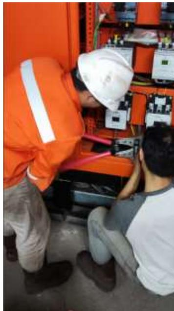
Gambar 2. 5 Proses Wiring Kontaktor 3 phasa untuk motor *Feeder Breaker*
